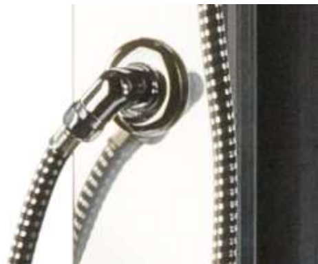
montáž hadice sprchy k vyústeniu sprchovej armatúry
