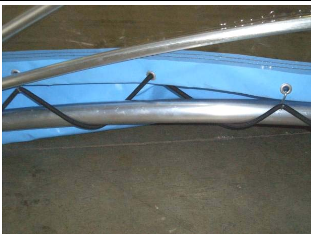
Obrázok C Upevnenie plachty lankom a háčikmi k obvodovým nosným oblúkom.
