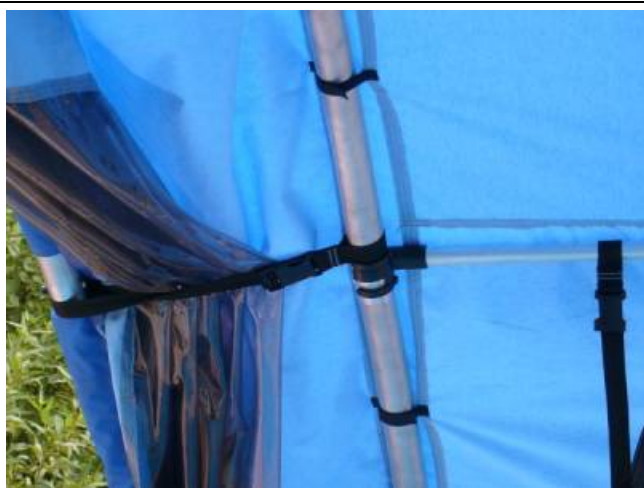
Obrázok I Zaistenie nosných oblúkov (A) v otvorenej polohe pomocou popruhov
